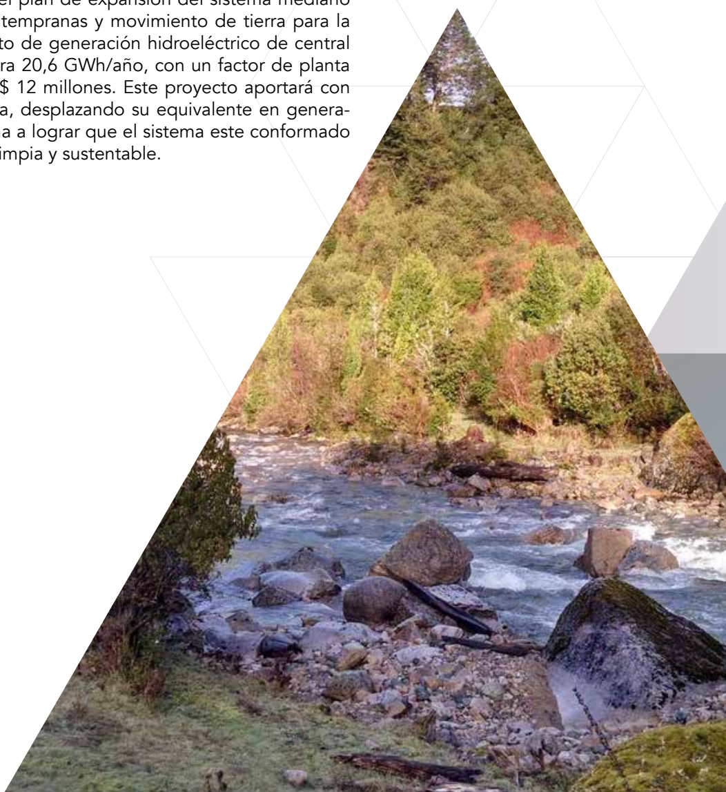
CENTRAL HIDROELÉCTRICA DE PASADA SAN VÍCTOR
