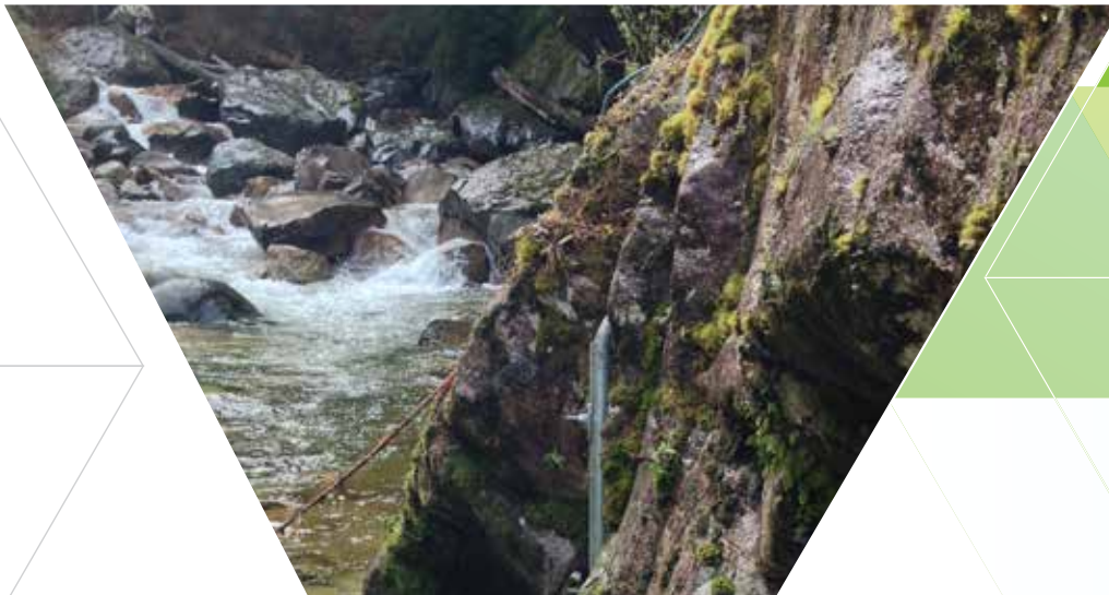
CENTRAL HIDROELÉCTRICA DE PASADA LA ARENA
