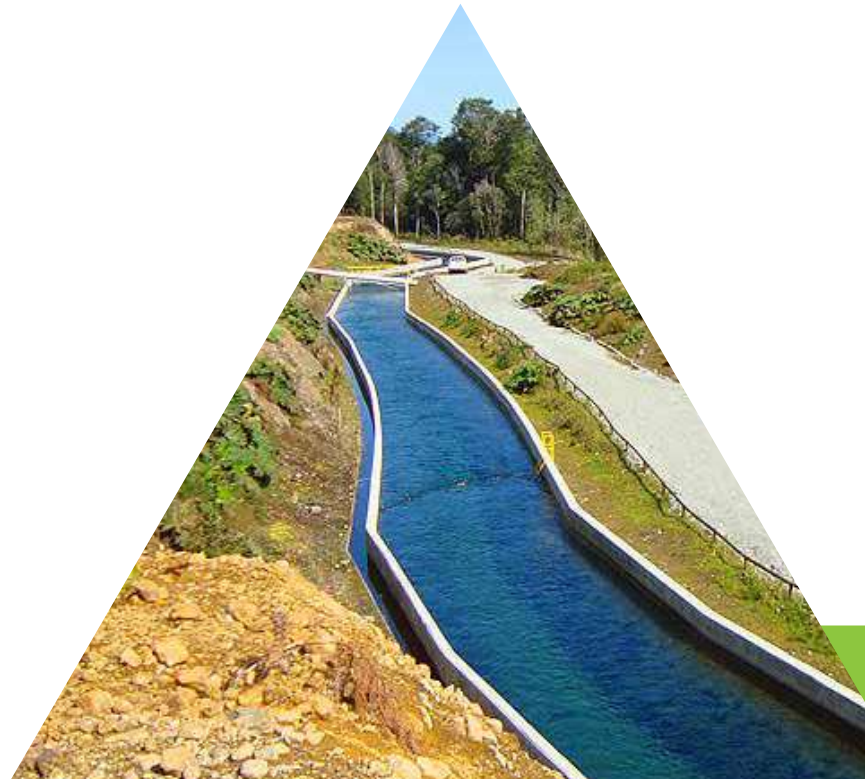
CENTRAL HIDROELÉCTRICA DE CUCHILDEO
